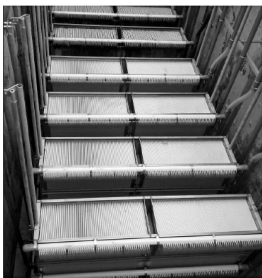
液中膜据付状況
