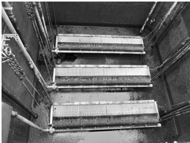
液中膜据付状況(1年目点検時)
